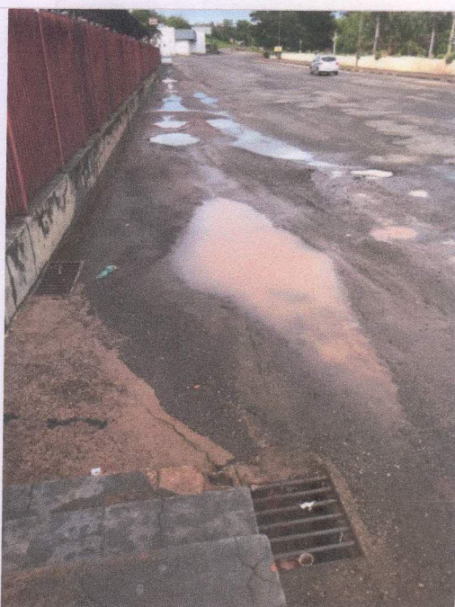
Foto 06 Ausência de rampa de acessibilidade
