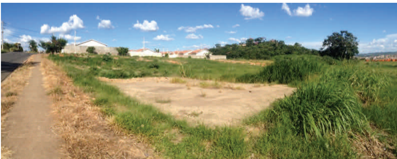
Figura 04– Vista da área cimentada nivelada por taludes, no terreno de implantação da creche.
